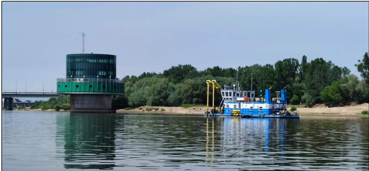
Fot. 4 Chudy Wojtek II na tle Ujęcia Zasadniczego – Grubej Kałki (fot. P. Bartold, 2022)
