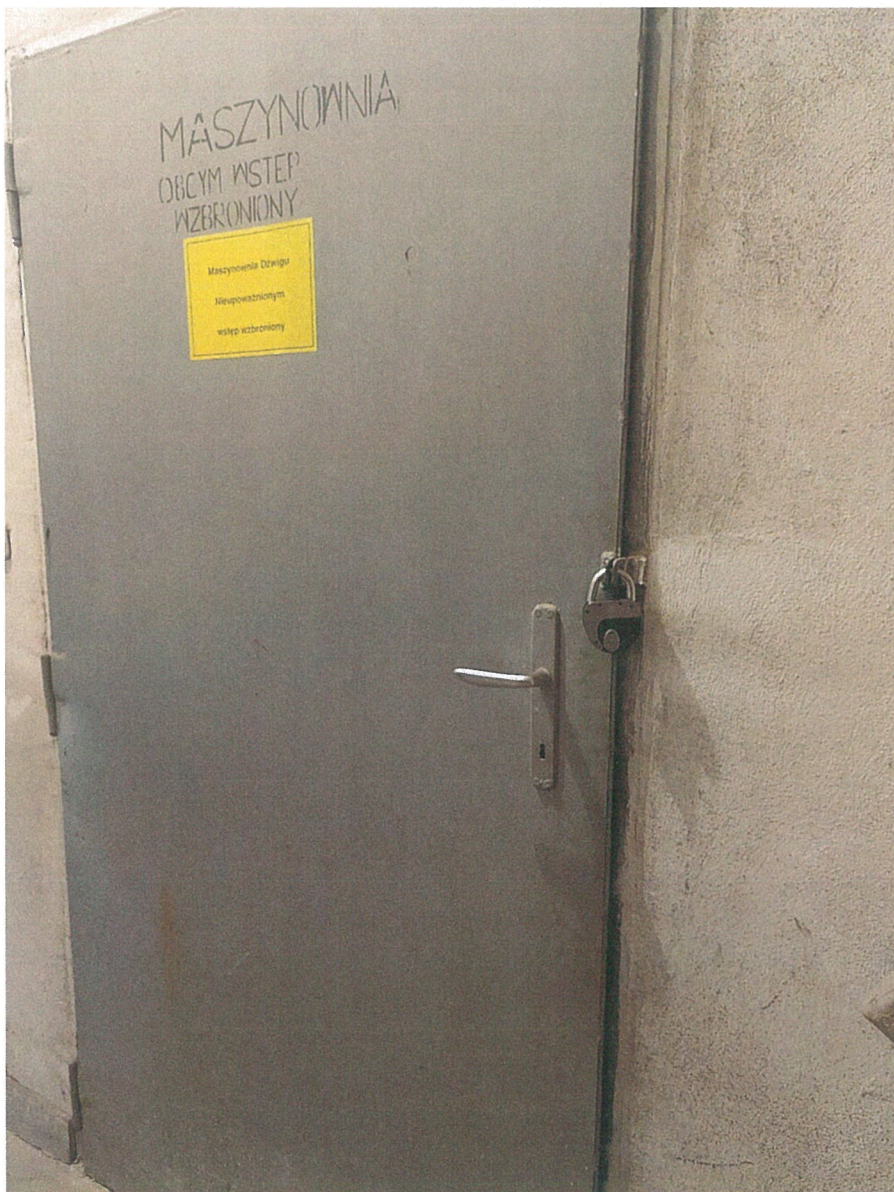
Drzwi do maszynowni dźwigu.
