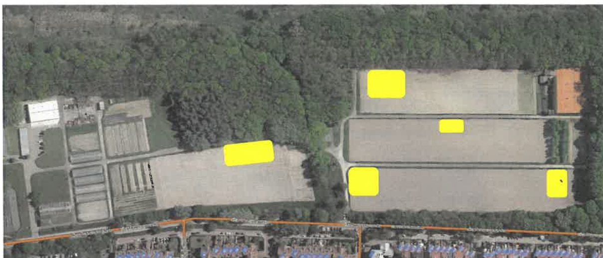
Lokalizacja miejsc nadmiernie uwilgotnionych i okresowo podtapianych
