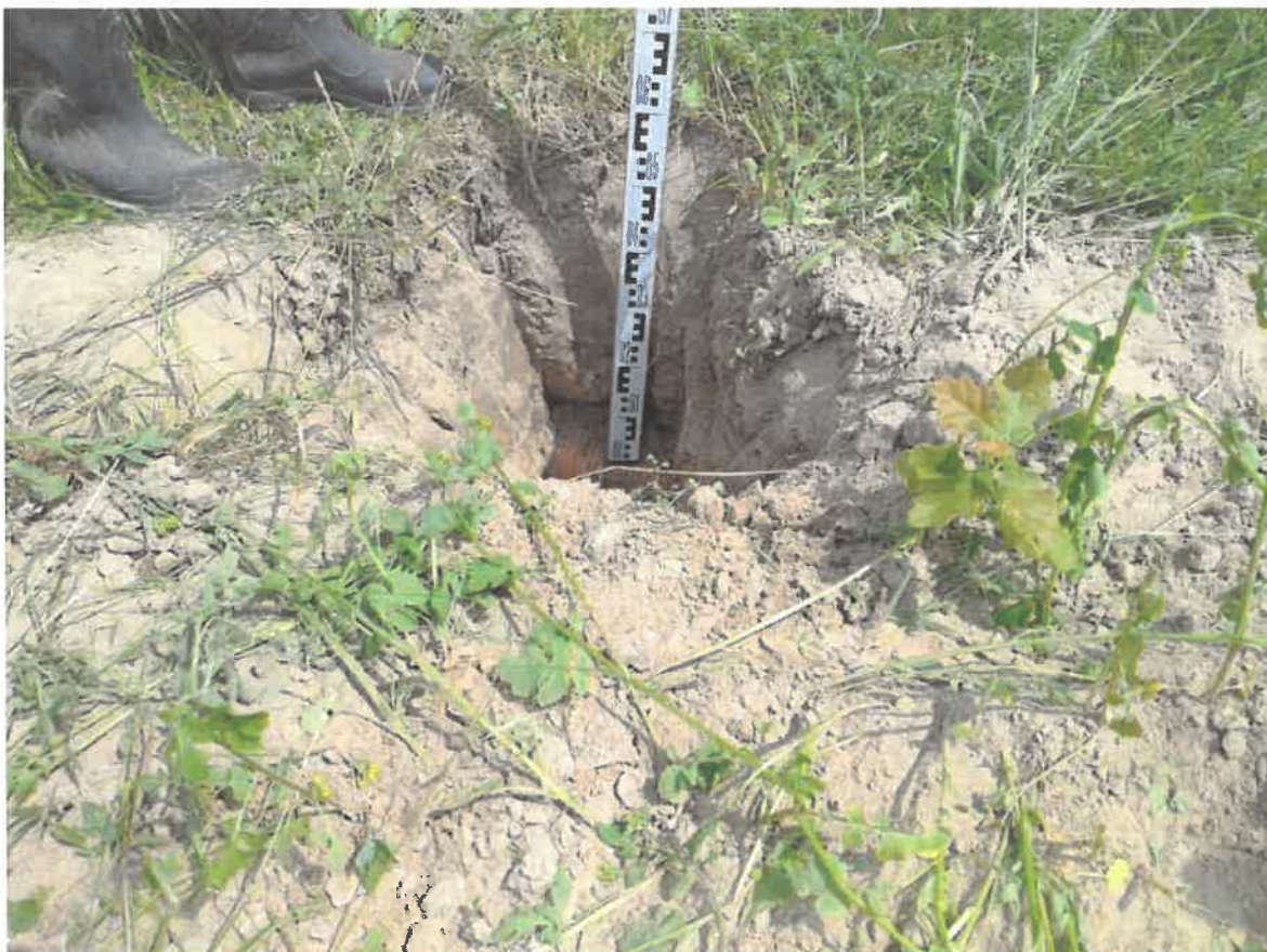
Dwa płytkie i niewielkiej długości rurociągi w centralnej części pola nr 1, od strony skarpy Ursynowskiej
