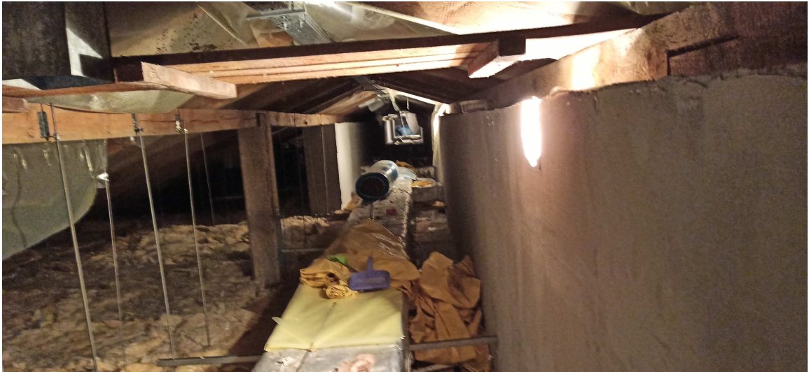
Widok ścian podpierających płatwie pośrednie, widok ocieplenia sufitu, widok kanałów wentylacyjnych
