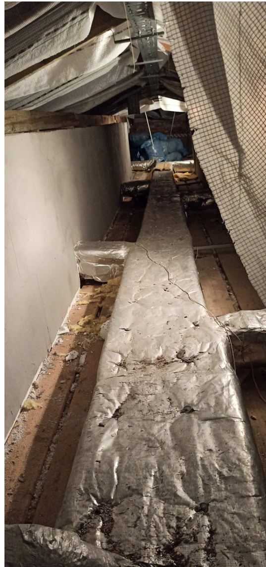
Widok połączenia odpowietrzenia pionów kanalizacyjnych z kominkami dachowymi wentylacyjnymi
