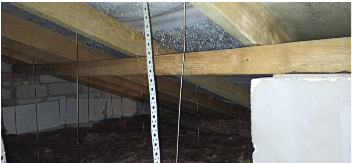
Widok konstrukcji podwieszenia systemowego sufitu kasetonowego
