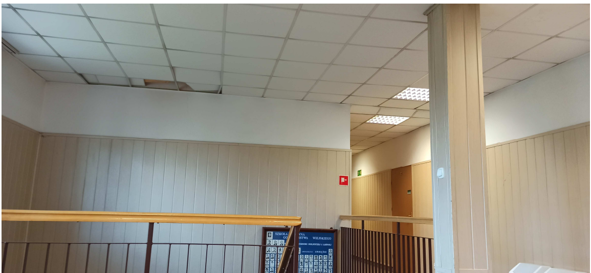
Sufit podwieszony kasetonowy w poziomie 1 piętra
