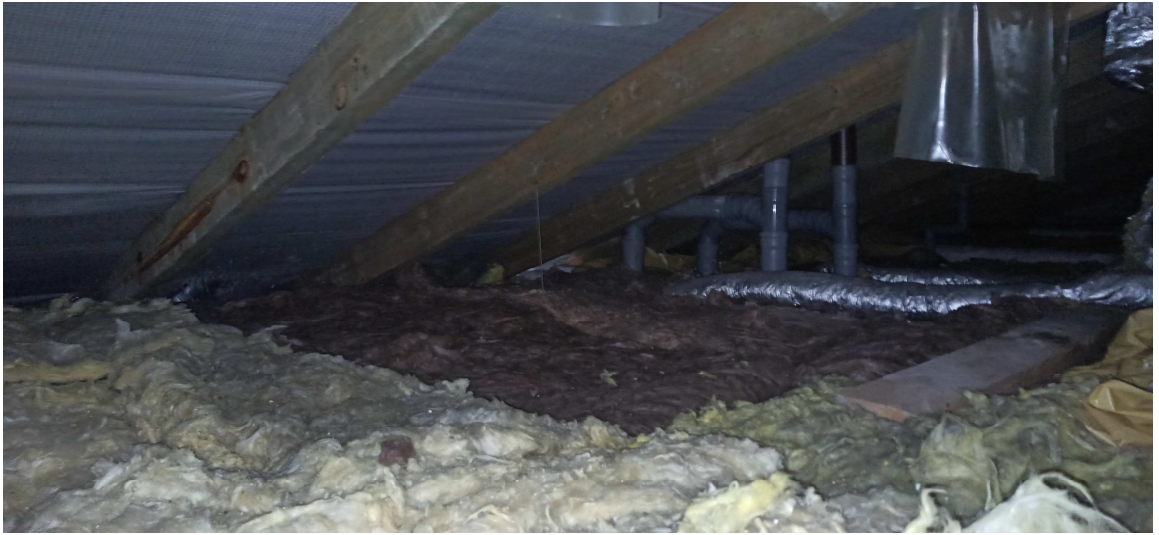
Widok połączenia odpowietrzenia pionów kanalizacyjnych z kominkami dachowymi wentylacyjnymi
