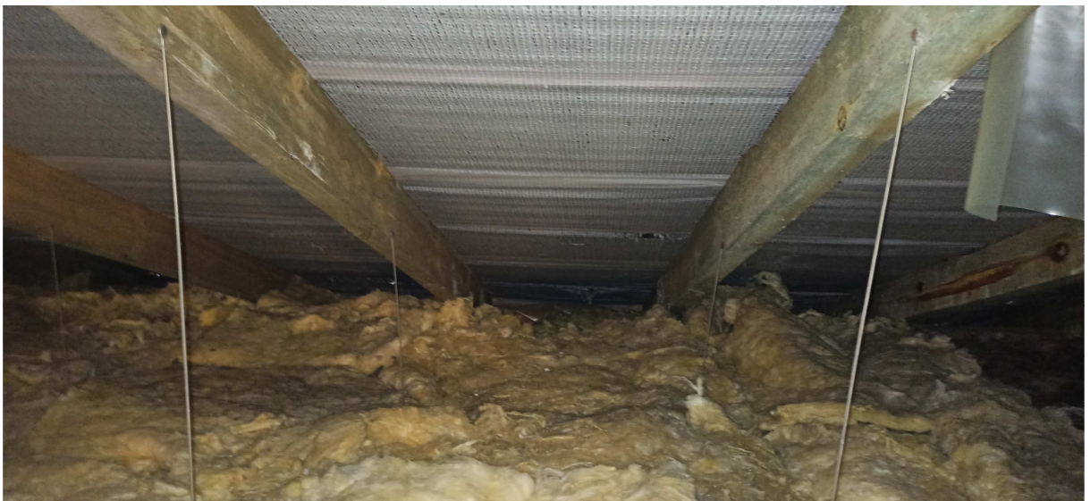
Widok ocieplenia sufitu podwieszzonego – wełna mineralna
