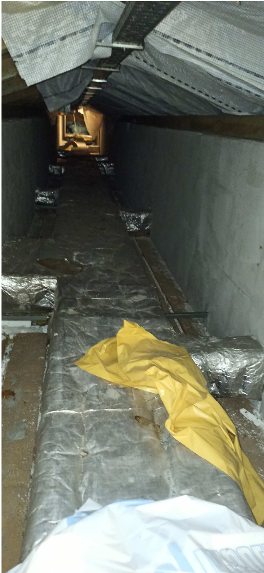
Widok traktu środkowego poddasza nieużytkowego
