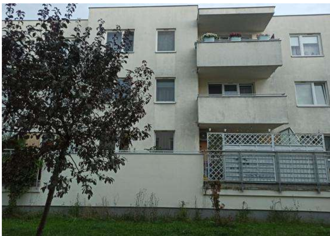
Rys. 8.1. Widok budynku referencyjnego od strony północno-zachodniej [rysunek własny]
