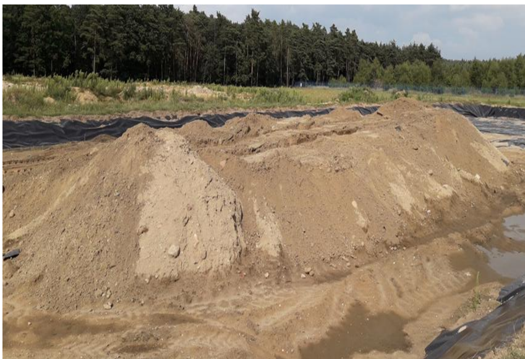
Rys. 7.8. Formowanie pryzmy bioremediacyjnej.
