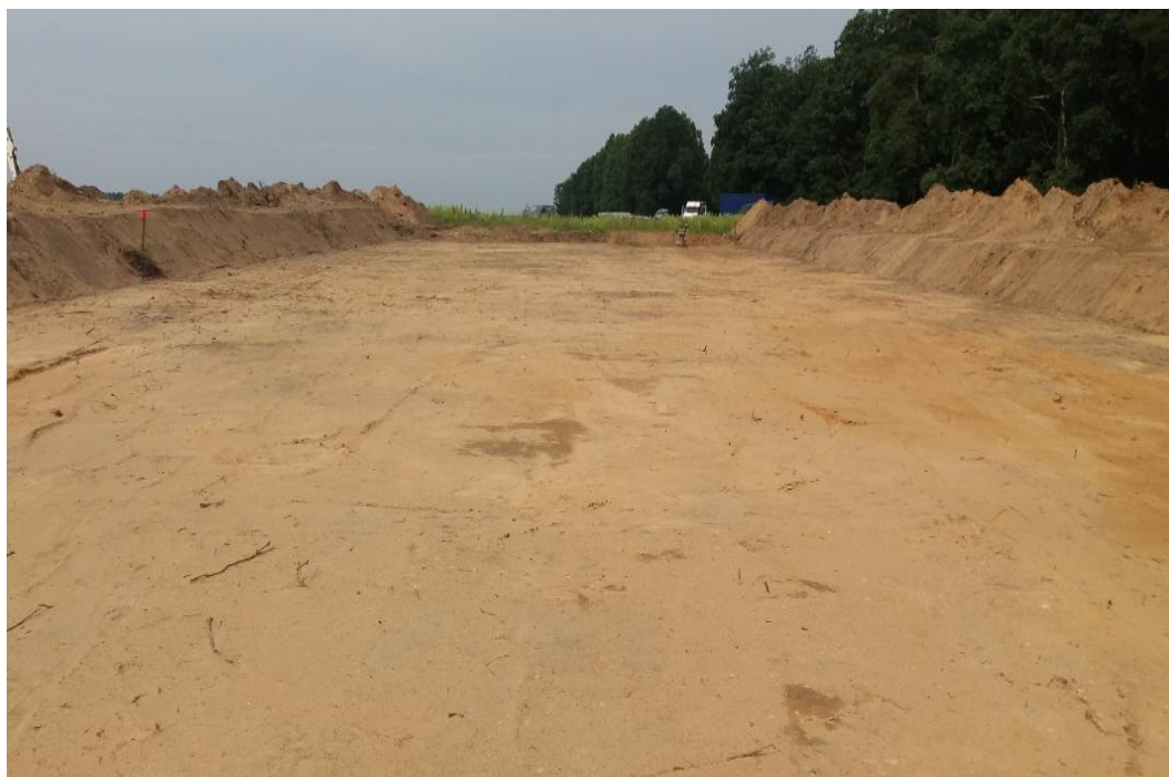
Rys. 7.7. Przygotowanie podłoża pod pryzmę bioremediacyjną.
